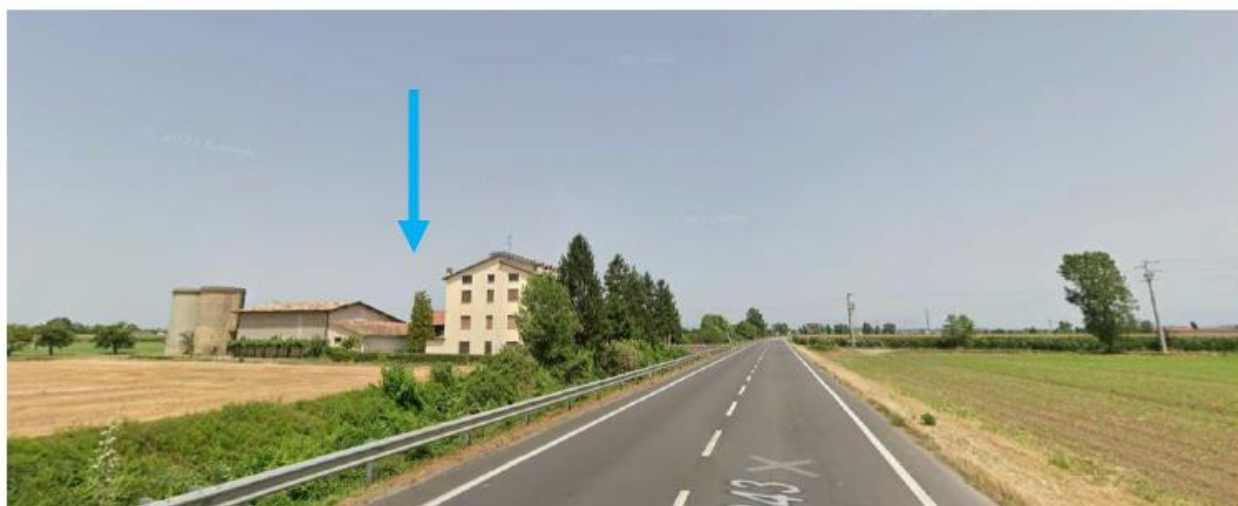
F. Vista della Cascina Bagolino dalla S.P. n. 343 da Acquafredda verso Carpenedolo
